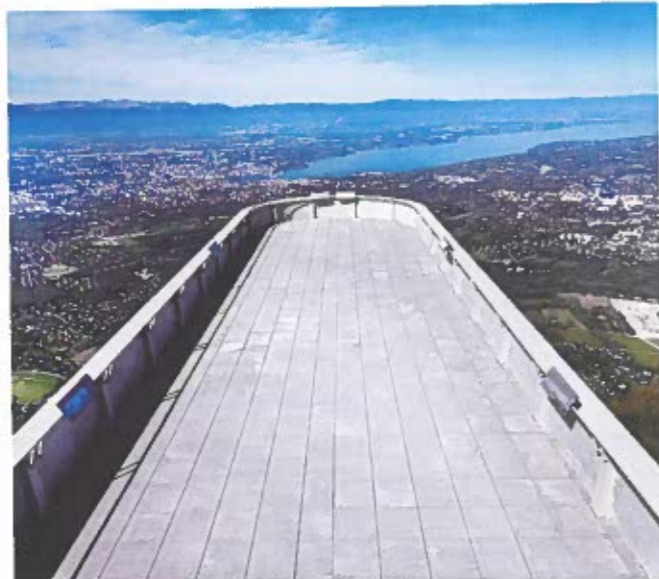
↑ La terrasse et le panorama révélé après deux années de chantier.
