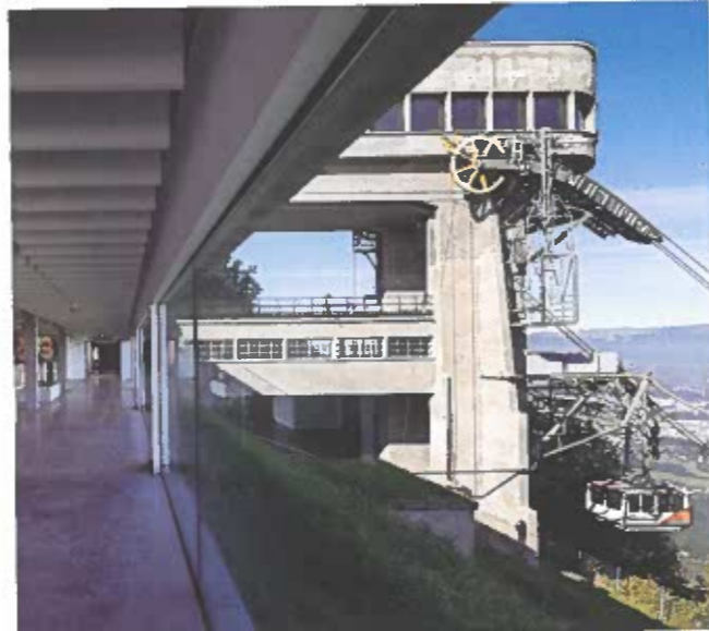
↑ Vue extérieure de la gare restaurée.
