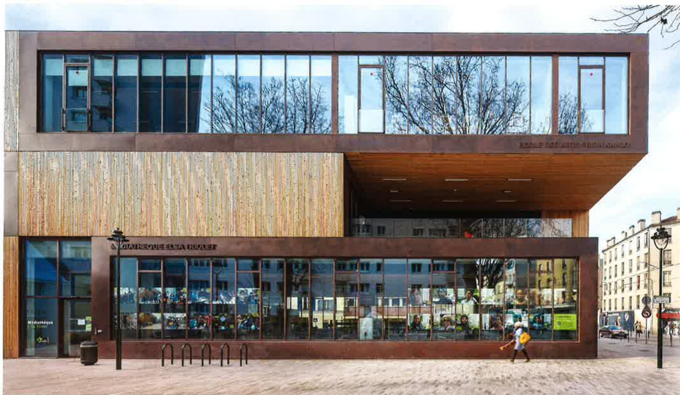
Le bâtiment se présente comme un empilement de boîtes en mélèze calepinées à des cassettes métalliques.
