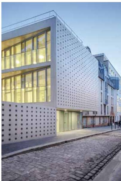
Les volumes en encorbellement et ceux de grande portée sont repris par les voiles à grand élançement fonctionnant suivant la méthode des bielles et tirants. Des échantillons et prototypes grandeurs réelles ont été réalisés sur site avec du béton coulé en place, pour l'incorporation au coulage des pavés et valider les modes constructifs des éléments en béton visibles : aspect glacé de la peau coffrante, teinte, mode de déversement du béton, vibration ou non, angles de dépouilles, etc.
